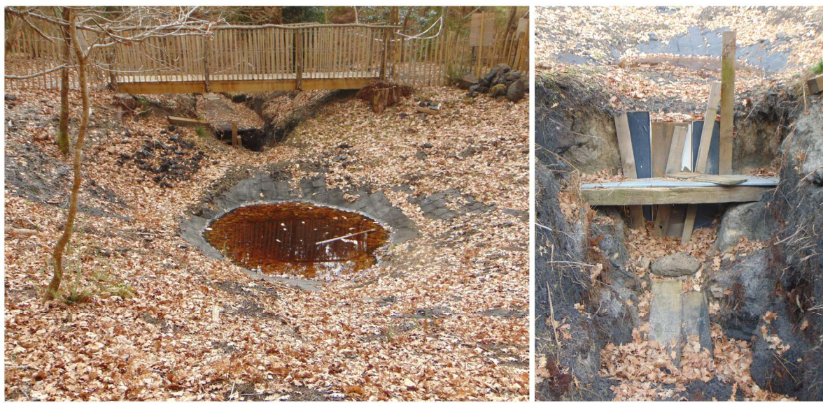
Photos du four à goudron fin XVII de Lesperon en cours de fouille : à gauche fond du four, à droite sortie du goudron par une canalisation en bois
